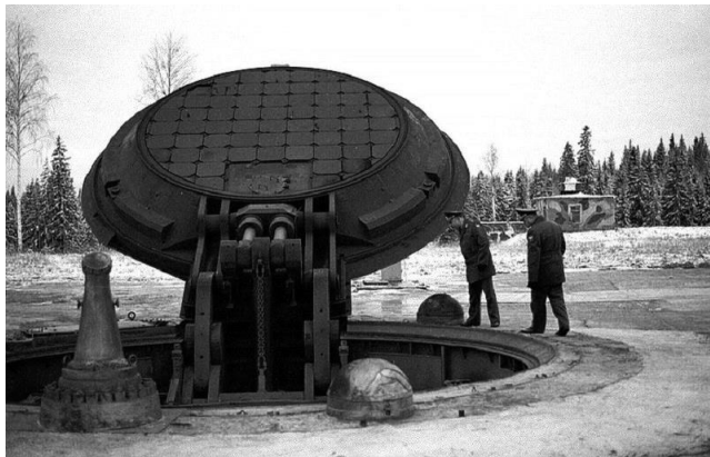
Покрив на подземен ракетен силос, соодветен за лансирање на „Сармат“.
